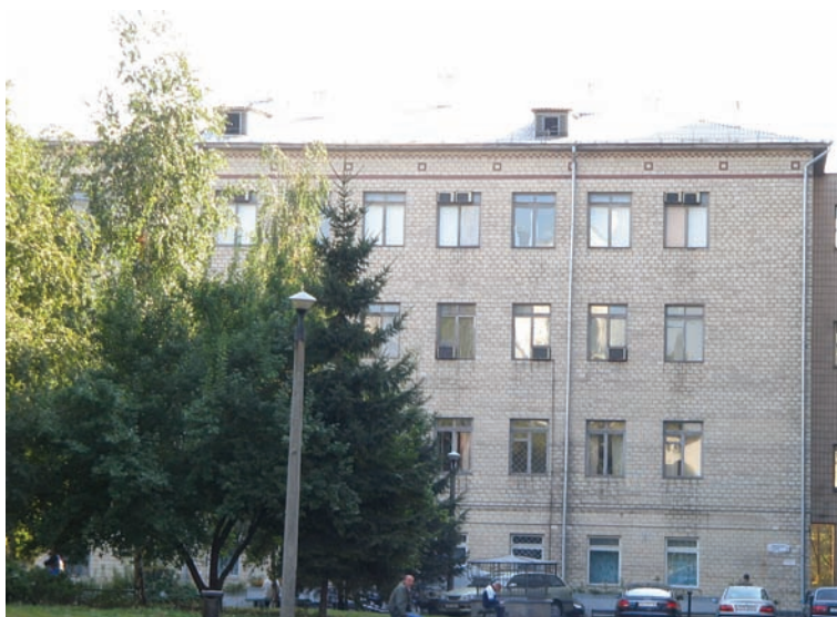
Чотириповерховий корпус Інституту, збудований в 1964 році
